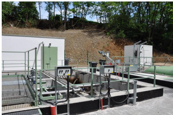
Byly vybudovány dvě nové nádrže a následně osazeny novou technologií čištění splaškových vod
