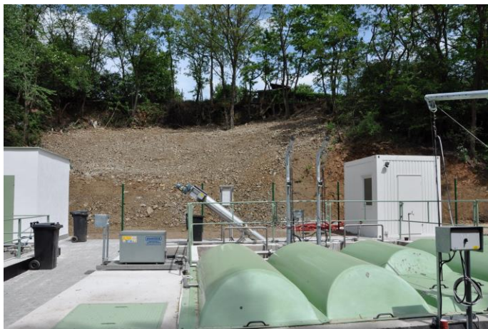
Byly vybudovány dvě nové nádrže a následně osazeny novou technologií čištění splaškových vod
