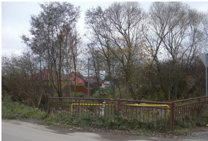
čištění břehů začalo u propustku na kyšické silnici...
