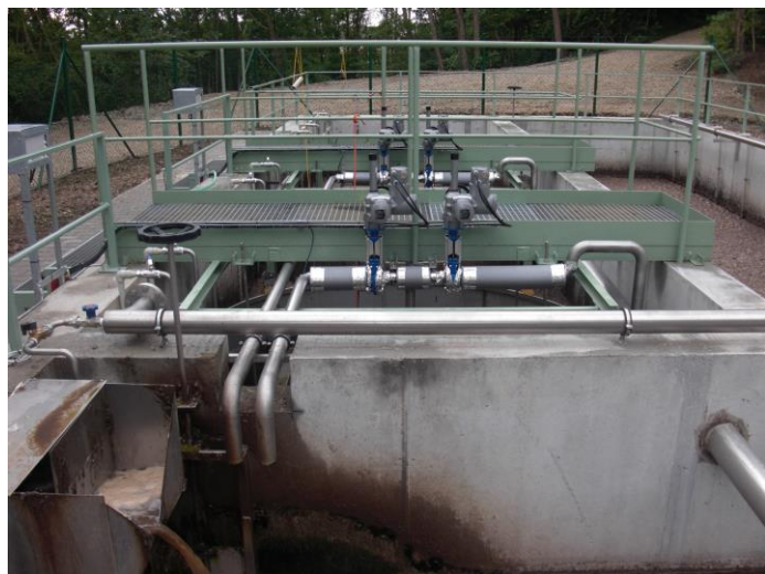
Byly vybudovány dvě nové nádrže a následně osazeny novou technologií čištění splaškových vod
