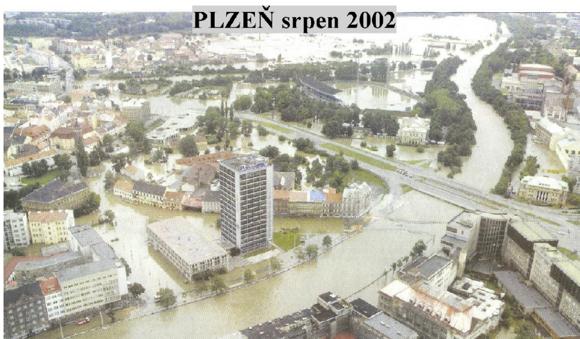
Anglické nábřeží, Pražská ulice, Sportovní areál Štruncovy sady a v pozadí část Roudné
