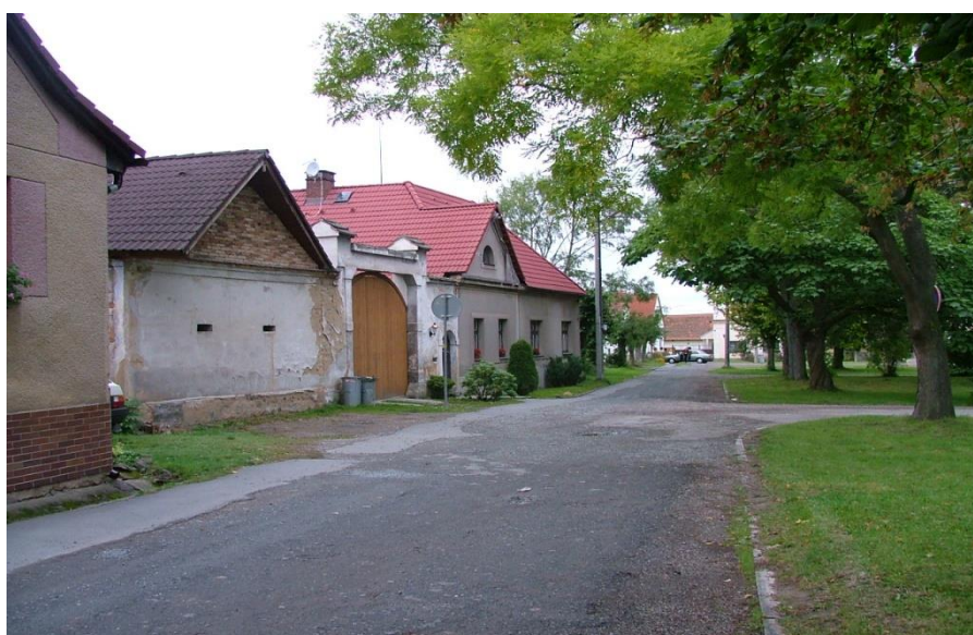
Nová střecha je i na usedlosti č. 18 u Ženíšků
