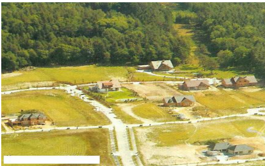
Pohled na výstavbu moderních vilek
