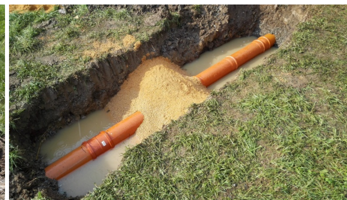
Opravy se dočkalo také letité potrubí, přivádějící vodu od studánky do vodní nádrže. K jeho poškození došlo s největší pravděpodobností opakovanými přejezdy těžké techniky – pravděpodobně v průběhu terénních protizáplavových úprav v roce 2014
