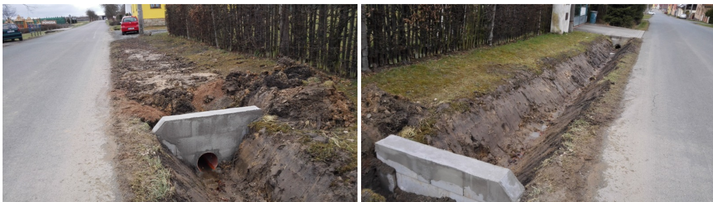
V průběhu roku se dostalo také na opravu části potrubí a příkopu dešťové kanalizace podél výjezdu silnice III. třídy (18018) směrem na Tymákov. Opravu provedla spol. Kanalizace a vodovody St. Plzeň, a.s.
