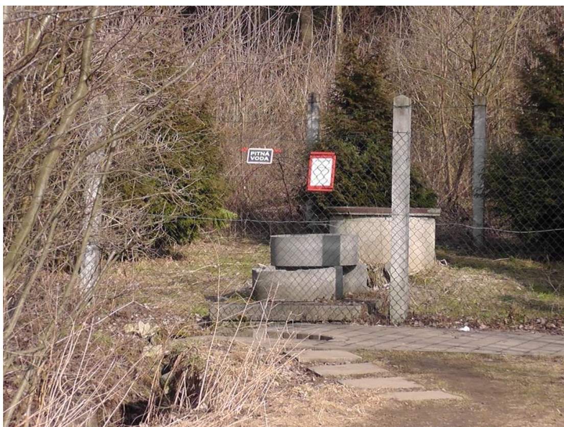
Studánka s pitnou vodou u koupaliště v obci Letkov
