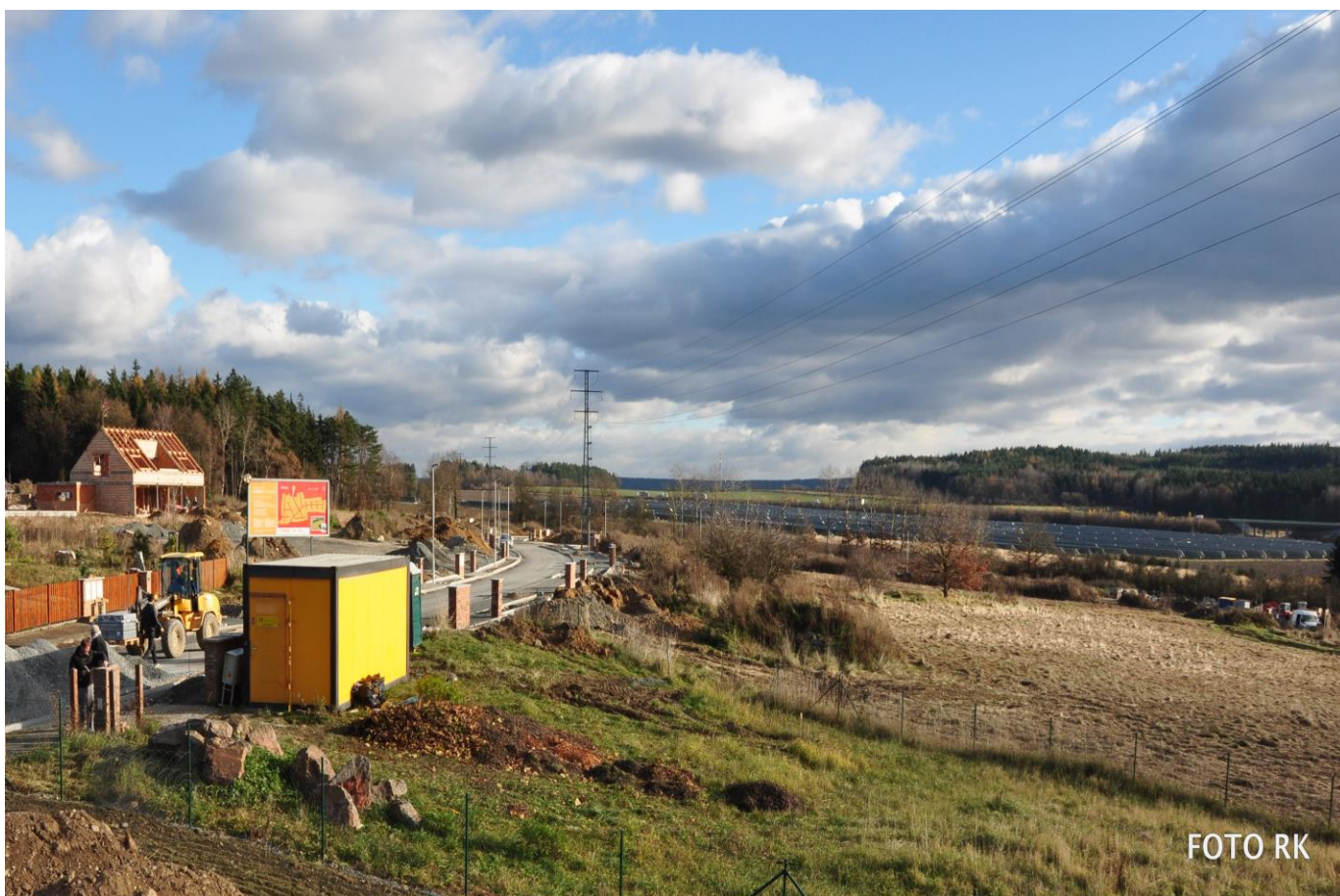
buduje se nový úsek silnice (s pracovním názvem investora – ul. Stříbrná) a nová okružní křižovatka. V lokalitě už vyrůstá i první rodinný dům.
