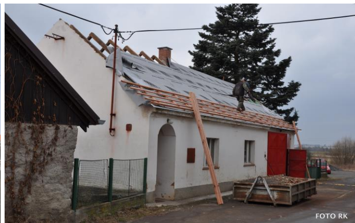
Nejdříve bylo nutné odstranit staré tašky a prohnuté latě, vyčistit půdu a opravit krokve
