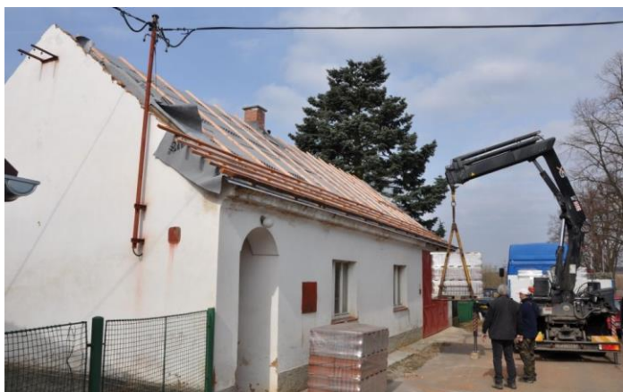
... a pak už zbývalo jenom položit nové tašky a instalovat nové okapy... - a bylo hotovo
