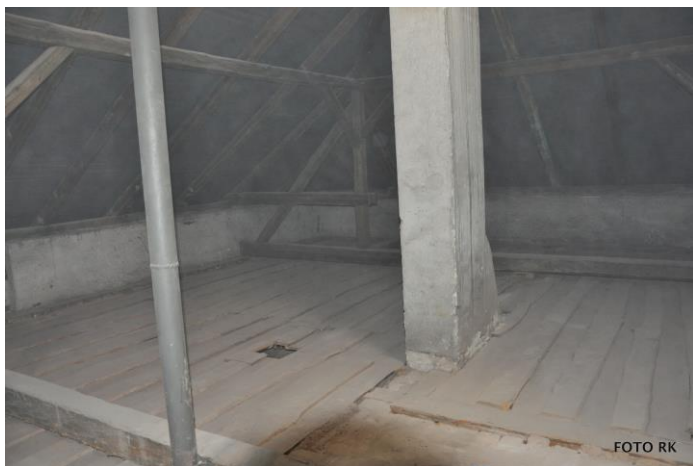
havarijní stav stropu vyžadoval rozsáhlou rekonstrukci - především s ohledem na plánované využití podkroví
