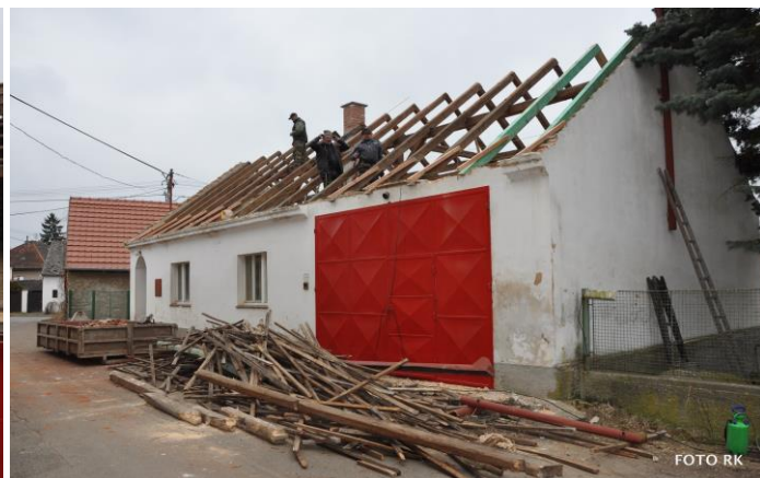
Nejdříve bylo nutné odstranit staré tašky a prohnuté latě, vyčistit půdu a opravit krokve
