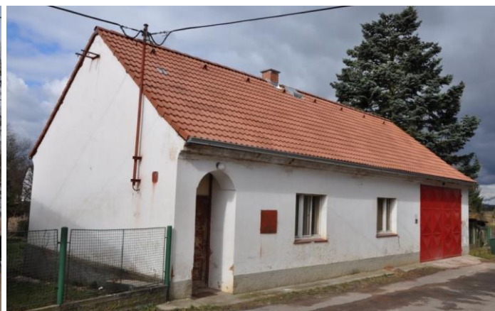
... a pak už zbývalo jenom položit nové tašky a instalovat nové okapy... - a bylo hotovo
