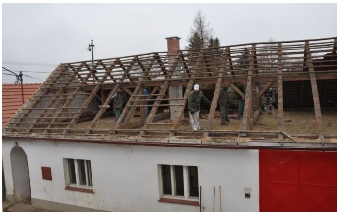
Nejdříve bylo nutné odstranit staré tašky a prohnuté latě, vyčistit půdu a opravit krokve
