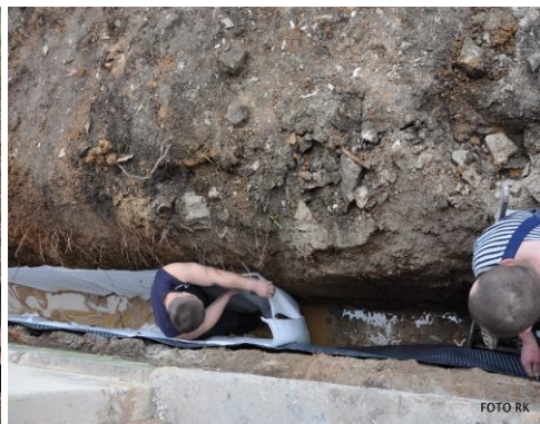
podél východní a severní stěny budovy bylo položeno odvodňovací potrubí
